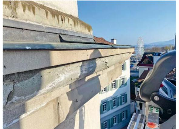
Der Fassadenputz ist im Grossen und Ganzen in gutem Zustand. Der 1985 aufgebrachte, dampfoffene Mineralfarbanstrich ermöglicht ein gutes Gleichgewicht im Feuchtigkeitshaushalt. Dennoch waren etliche Reparaturen nötig: Festigen von Hohlstellen, Füllen von Rissen, Teilersatz an der Apsis und Neumodellierung des Dachgesimses am Westgiebel.
